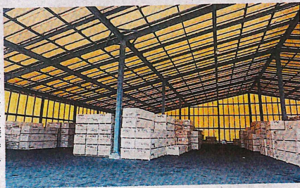
東海倉庫内のベトナム産LVL
