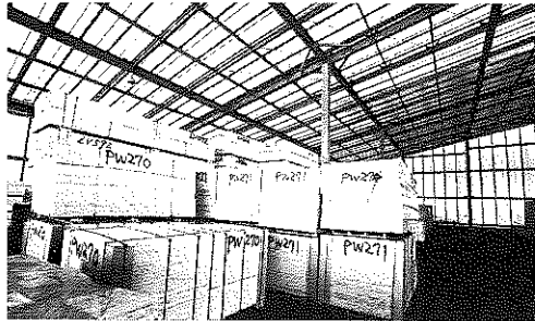
増設した屋根付き倉庫
