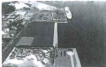
奥の船が着岸している場所が17号岸壁、その手前が16号岸壁、写真一番手前が15号岸壁 (提供：宮崎県北部港湾事務所)
